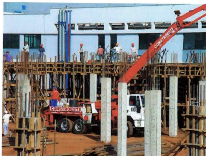
Fig. 2: Obras de ampliação
